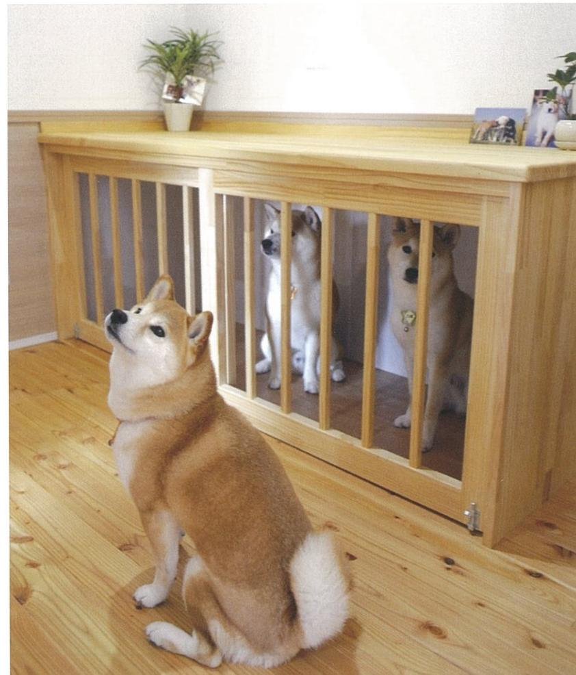
柴犬母娘が暮らす二世帯住宅N&K邸。収納下をケージにもなるドッグスペースに。床は重歩行用ビニル系シート、壁は汚れに強いメラミン系パネル、天井は湿度を調整して空気をキレイにする機能のある建材、気になるニオイを抑制する天井埋込型ナノイー発生機も装備。他の部屋に音が漏れにくいように、壁内に遮音材も充填しています。
